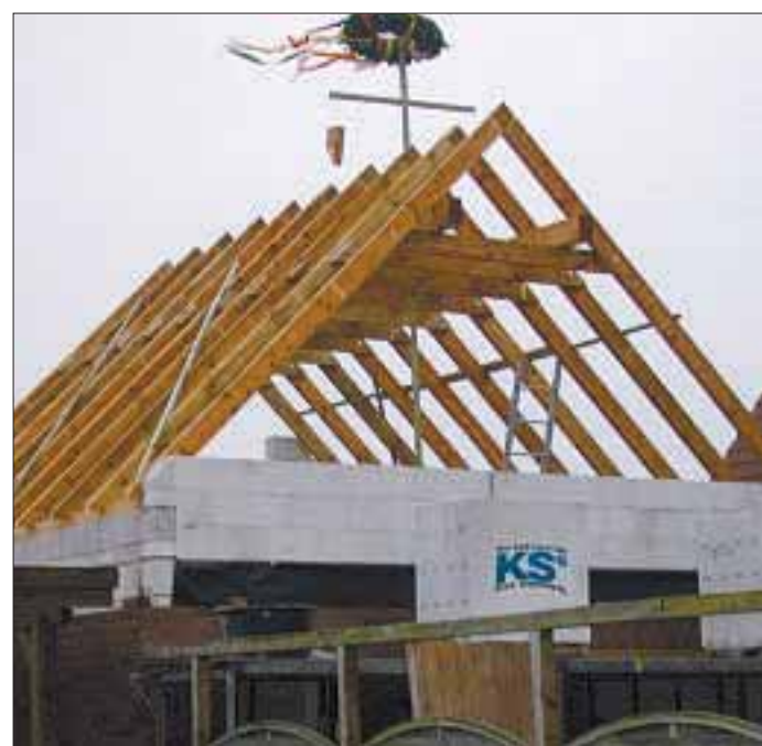
Nach dem Richtfest der Jugendwerkstatt fallen noch viele Arbeiten an. Alle Beteiligten freuen sich jetzt schon auf das Ergebnis ihrer Mithilfe. FOTO: GERKEN
