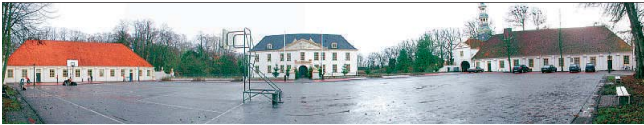
Das Ensemble aus (v.l.) Rentei-Gebäude, Schloss und Vorburg soll unter denkmalpflegerischen Gesichtspunkten zu einer Ganztagschule umgebaut werden.
